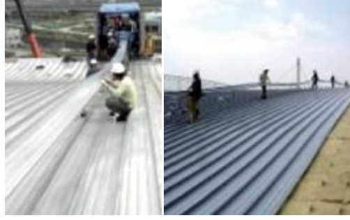
Yerinde sac (metal levha) kalıplaması
