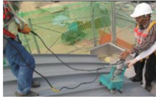
Çatı Panelinin üst üste oturtulması
