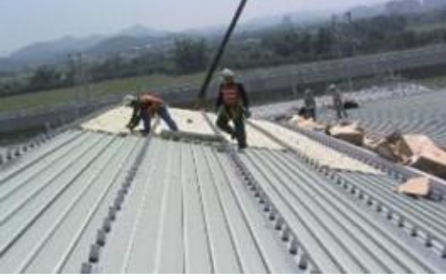
Taban sacı ve yalıtım malzemesi döşenmesi ve braket montajı
