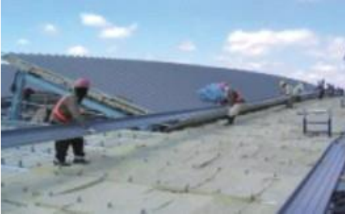
Çatı panellerinin eş zamanlı olarak serilmesi
